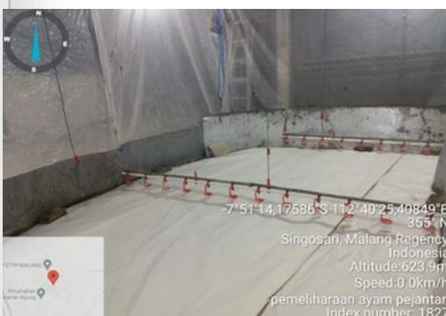
Pemasangan seng, tirai dan alas kandang
